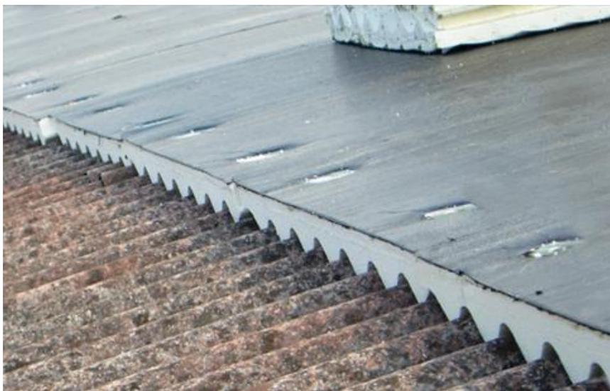
*Figura 10. Tetto in fase di confinamento. Nella parte sottostante è ancora visibile la vecchia copertura in fibro-cemento tipo Eternit.*
